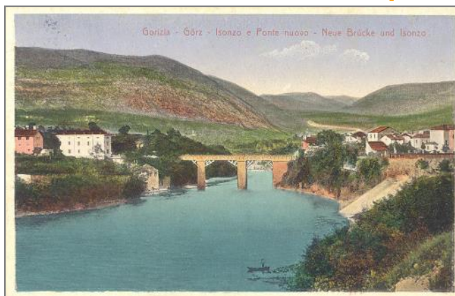
In una vecchia cartolina, la vallata dell'Isonzo con il ponte di Piuma e sulla sinistra il complesso delle “ex Case Fogar”, sullo sfondo il M. Sabotino. (archivio N. Tavagnutti)
